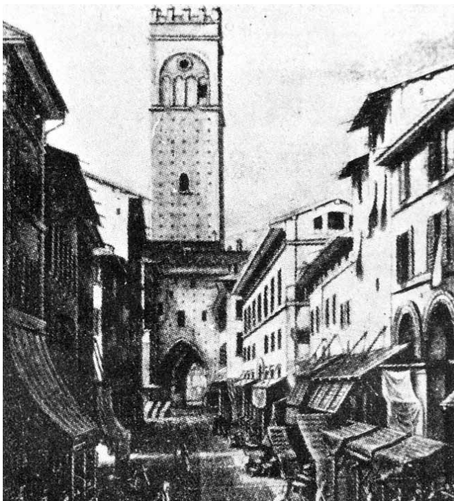
Via Degli Orefici
